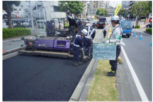
②アスファルト敷均し
