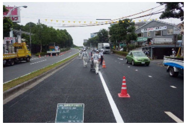
④区画線施工
