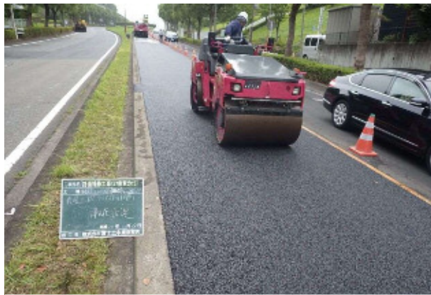
③アスファルト舗装転圧
