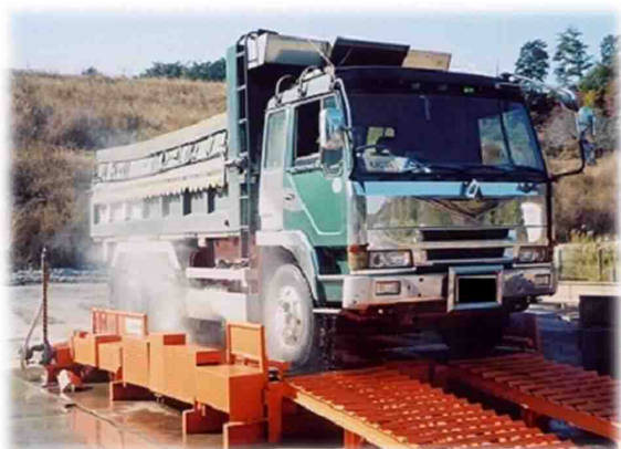
工事現場内での車両洗浄 イメージ
